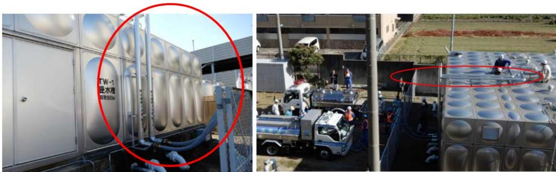
給水車からの給水を容易にし、給水時間短縮化と作業の安全化を図るため受水槽に給水車専用入水管を設置した事例 「大阪急性期・総合医療センター」
